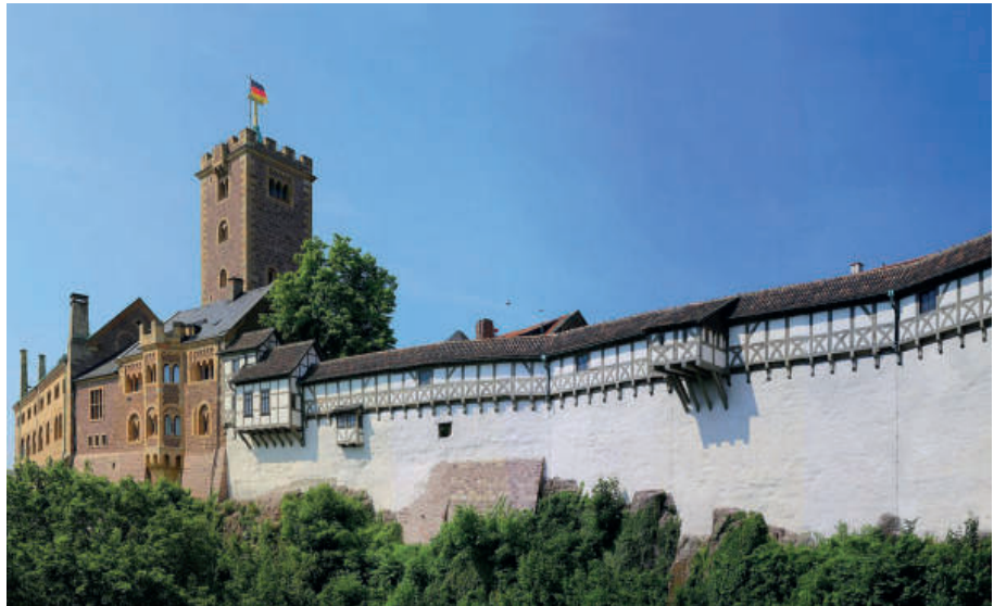
Panorama der Ostseite der Wartburg in Eisenach
